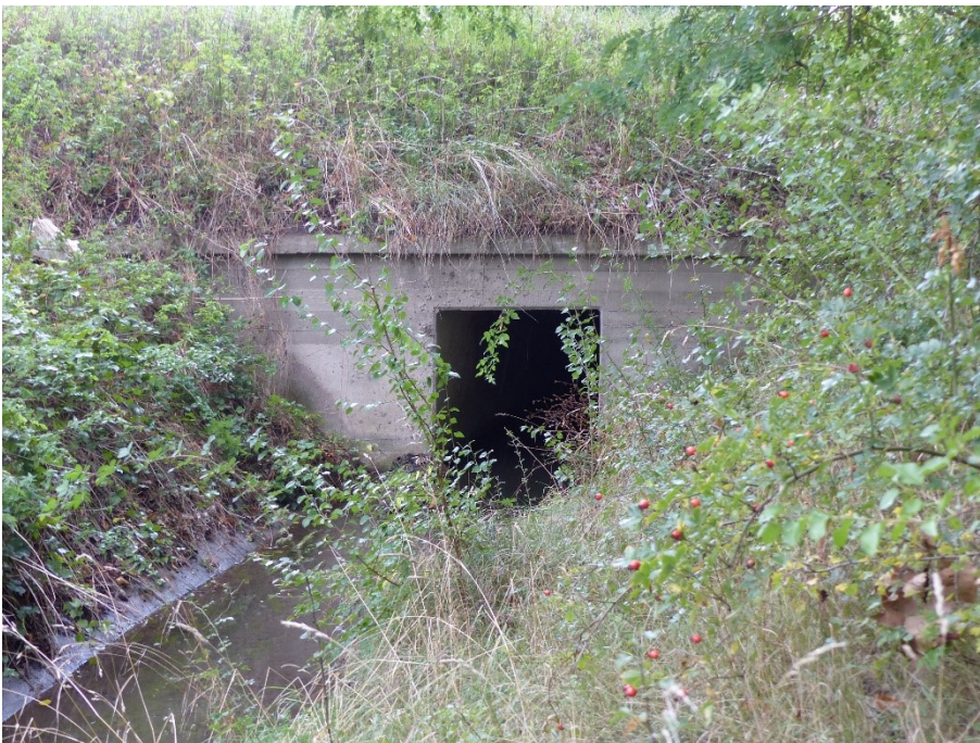
Bild 5: Durchlass unter der alten B 81
