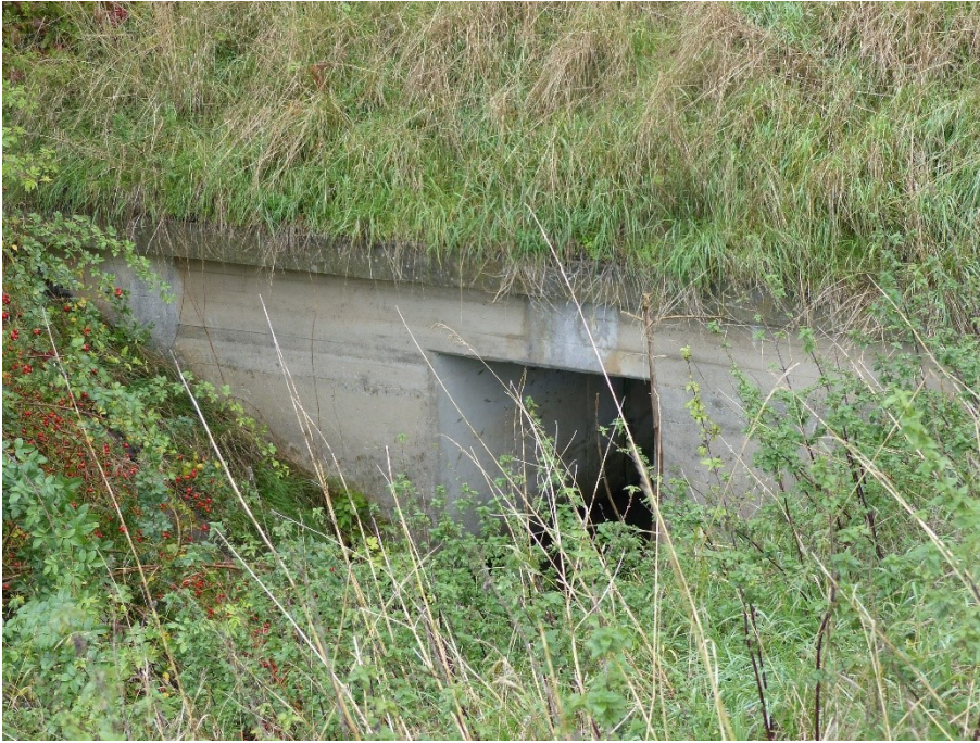
Bild 4: Durchlass unter der B 81
