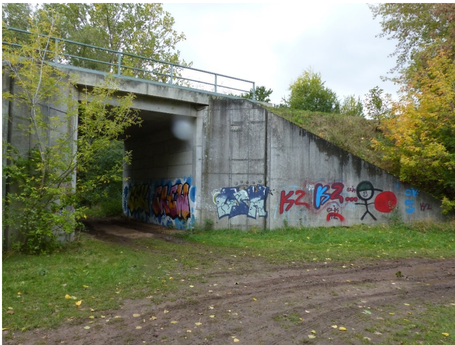
Bild 3: Querung der Bahnlinie, Der Seerennengraben ist unter dem Weg verrohrt.
