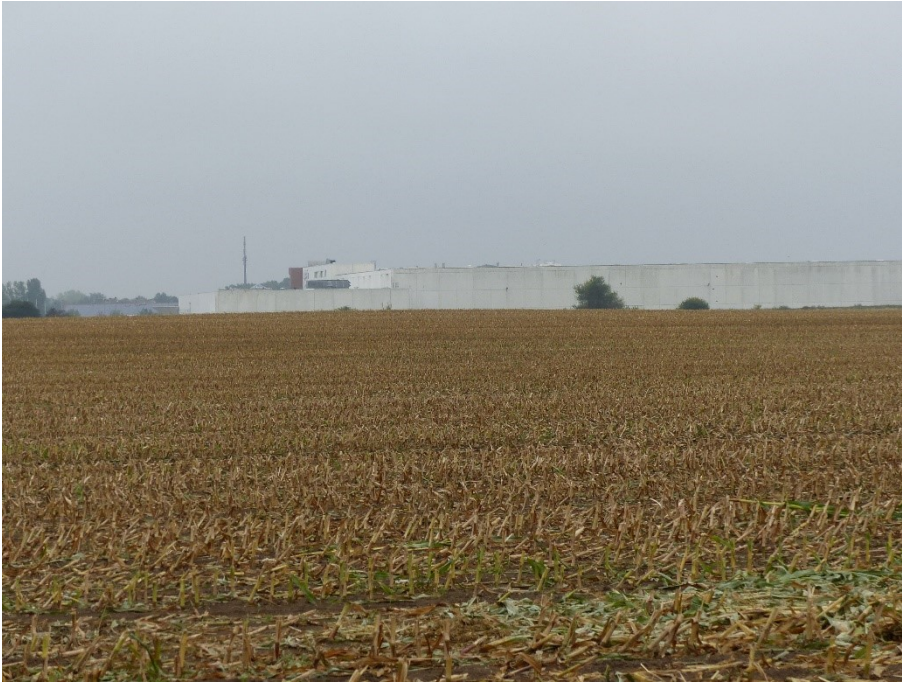
Bild 11 Blick auf das Gewerbegebiet Langenweddingen mit den unmaßstäblichen Gebäuden des ehemaligen Möbelmarktes, bestehende Störung
