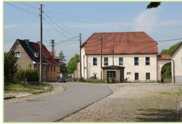
Abbildung 2 Sanierung des Salzblütenweges
