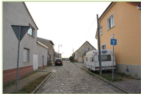
Abbildung 2 Grundhafte Sanierung der Neustraße
