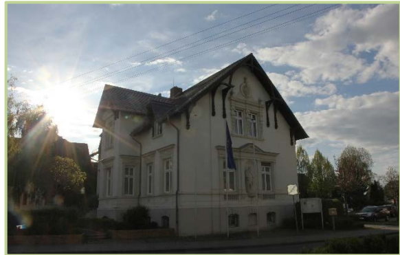
Abbildung 2 Sanierung des Bürgerhauses
